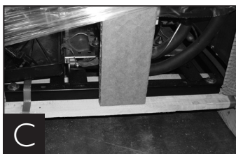
Демонтаж транспортировочной подставки с днища шкафа.
