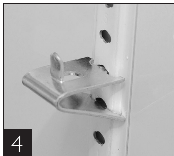
4 Einbau der Bodenträger abgeschlossen
