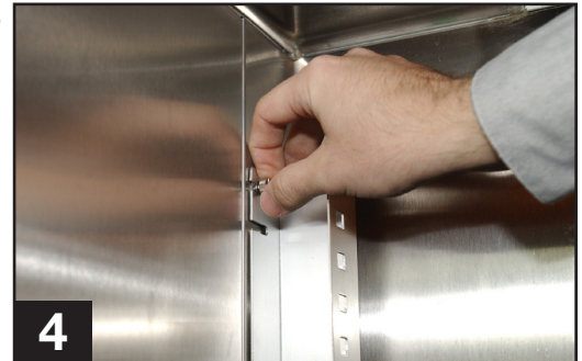
Instalación de las Pilastras (Pared Lateral del Gabinete)
