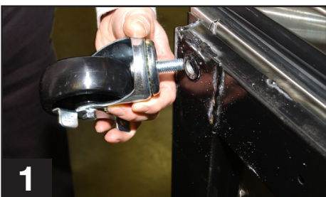
Atornille la rueda en la parte inferior de la base del gabinete.
