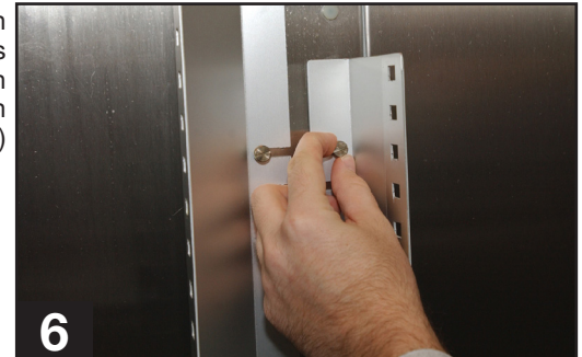
Installatie van pilasters (Achterwand van kast / modellen met 2 of 3 deuren)
