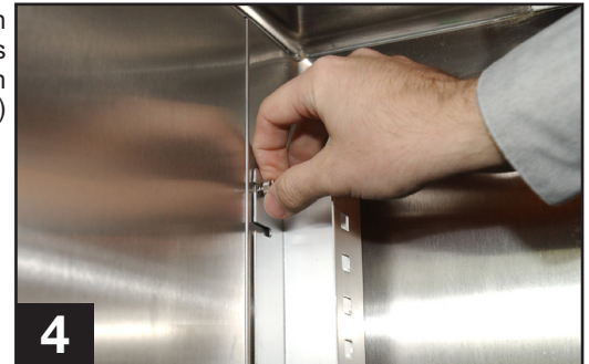
Installatie van pilasters (zijwand van kast)
