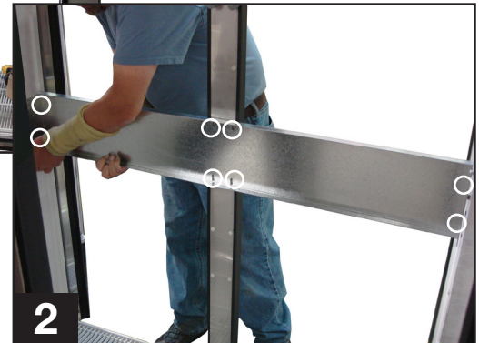
2 Steun verwijdering. Schroef locatie.
