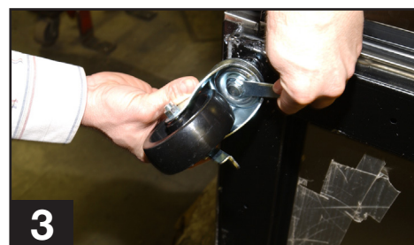
Gebruik het meegeleverde gereedschap om het wiel op zijn plaats aan te draaien.
