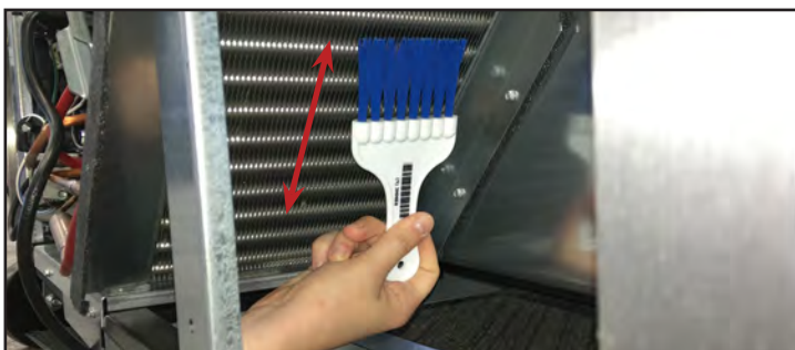
Рис. 3. Запрещено проводить щеткой поперек ребер змеевика.
