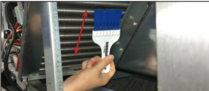
Abb. 3. Niemals über die Lamellen des Registers bürsten.
