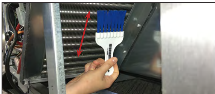
Fig. 3. Ne brossez jamais en travers des ailettes du serpentin.
