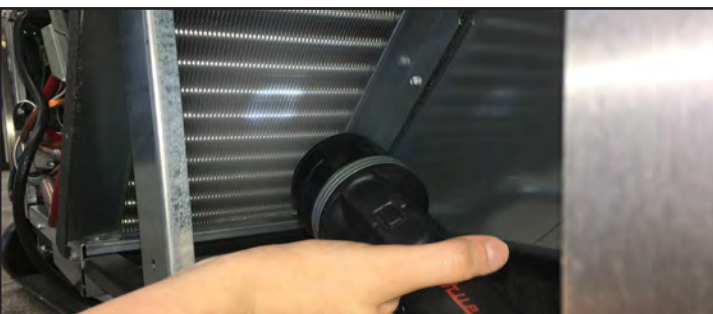
Afb. 4. Controleer of alle verstoppingen verwijderd zijn.
