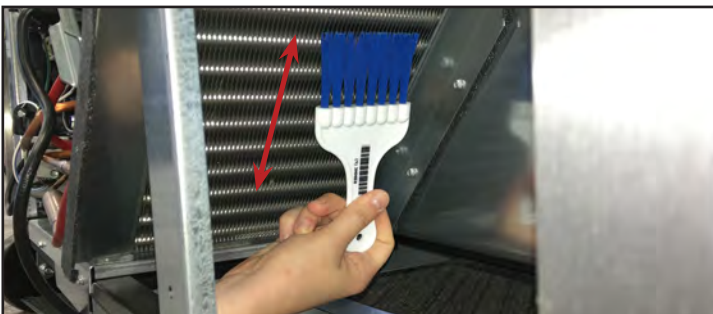
Afb. 3. Borstel nooit dwars over de ribben van de spiraal.
