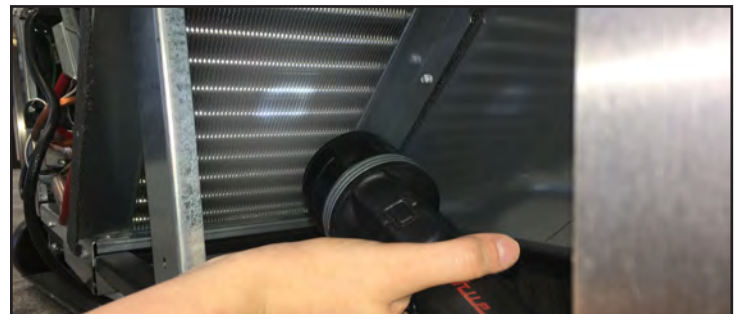
الشكل ٤. تأكد من إزالة جميع الانسدادات.
