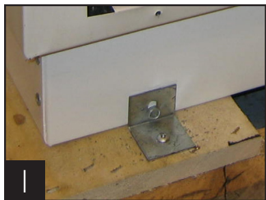
Dépose des pattes de base qui attachent l'armoire à la palette d'expédition.
