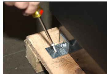
Fig. 3. Si lo hay, retire el soporte en forma de L.
