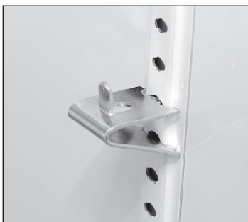
Fig. 4. Elemento de fijación del estante instalado.
