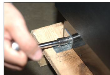
Rys. 2. Usunąć wspornik transportowy szklanych drzwi uchylnych, jeśli są w niego wyposażone. Nie wyrzucać.
