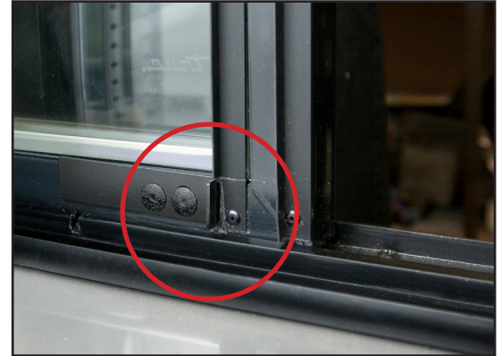
Abb. 2 Feststellriegel geschlossen (nicht in Nocke eingerastet)
