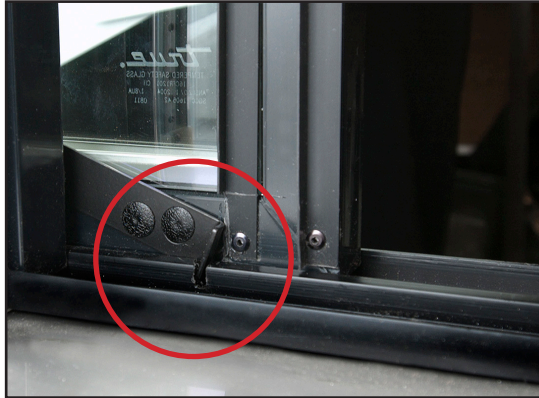
Abb. 1 Feststellriegel geöffnet (in Nocke eingerastet)
