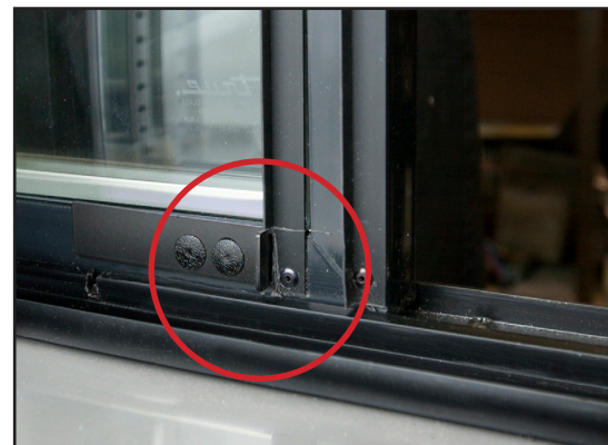
Fig. 2. Le verrou de la porte est en position fermée (désengagé de l'encoche).
