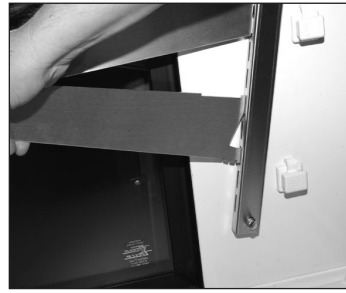
Abb. 6. Die Bodenträger in der gewünschten Höhe in die Stangen einhaken.
