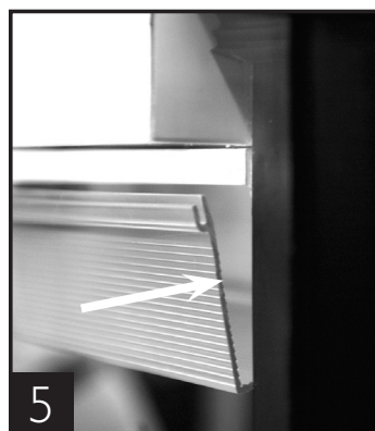
Colocando el canal en "U" del protector sobre el soporte de metal.
