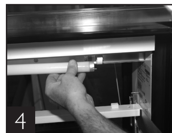
Retirer l'ampoule en la repoussant légèrement dans la douille à ressorts.
