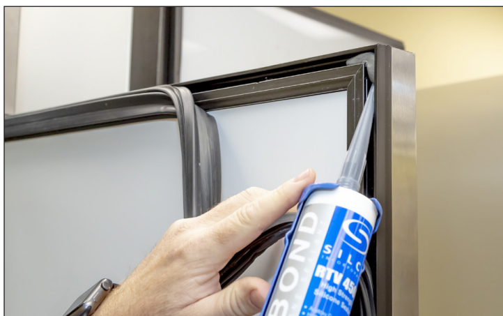
Рис. 3. Нанесите силикон в каждом углу направляющей уплотнителя.
