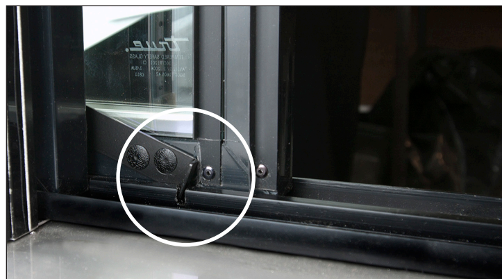
Rys. 1. Zatrzask drzwi jest w pozycji otwartej (zatrzaśnięty z wycięciem).
