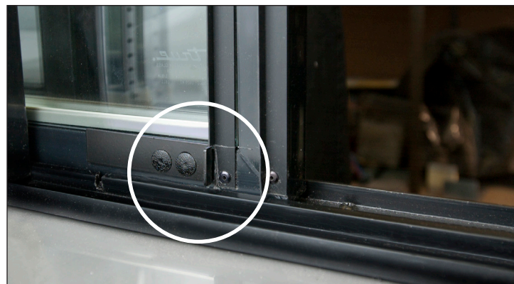
Abb. 2 Feststellriegel geschlossen (nicht in Nocke eingerastet)
