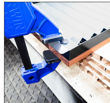
Fig. 2. Centrez le recouvrement et la grille dans les coins. Le panneau est légèrement plus grand que la grille.
