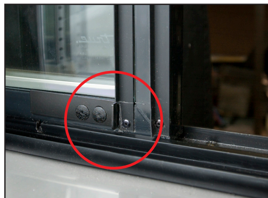
Fig. 2. Il chiavistello dello sportello è in posizione chiusa (fuori dall'intaglio).
