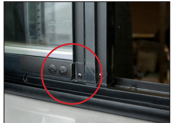
Abb. 2. Türverriegelung ist in der geschlossenen Position (aus Kerbe ausgerastet).
