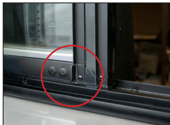
Afb. 2. De deursluiting staat in de gesloten stand (losgekoppeld van de inkeping).
