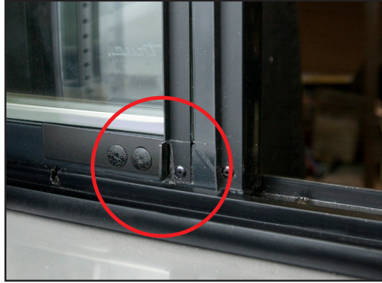
الشكل 2. مزلاج الباب في الوضع المغلق (مفصول عن القطع الجانبي).
