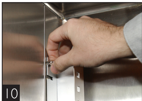
Instalación de las Pilastras (Pared Lateral del Gabinete)
