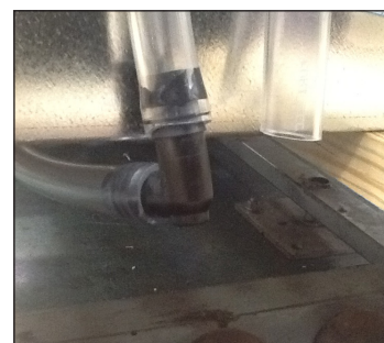
Fig. 6. Connettere il raccordo filettato ai tubi sull'armadietto.
