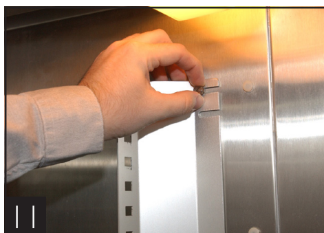
Installation des pilastres – modèles à deux et trois portes (milieu de la paroi à l'arrière du meuble)
