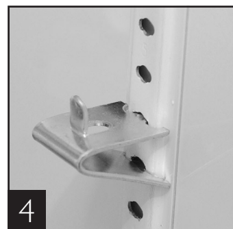
4 Instalación finalizada de los elementos de fijación del estante
