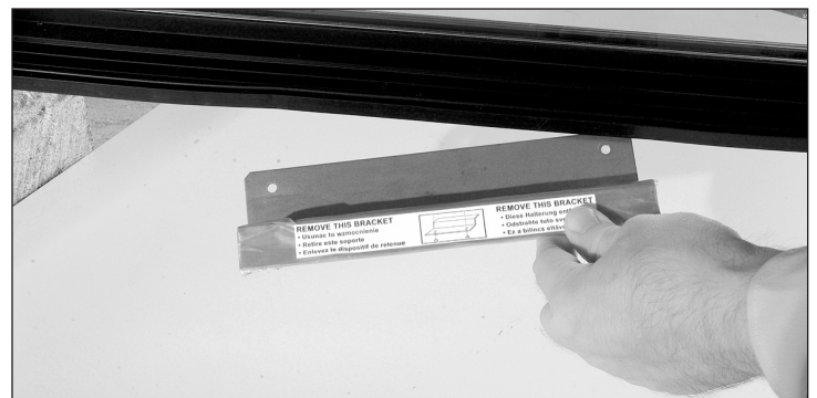
Abb. 2. Transportbügel der Glasschwingtür entfernen, falls vorhanden. Nicht wegwerfen
