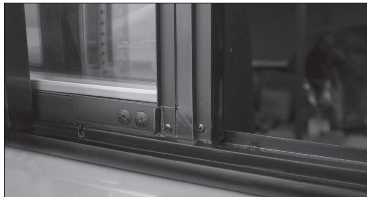
Afb. 2. De deursluiting staat in de gesloten stand (losgekoppeld van de inkeping).
