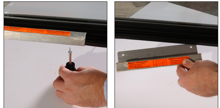
Fig. 2. Retire el soporte de transporte de la puerta de vaivén de cristal, si lo hay. No desechar.
